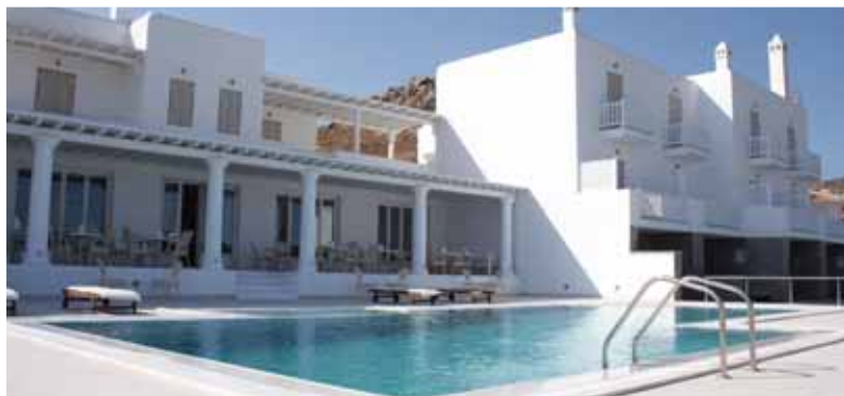
Piscina principale La Residence
